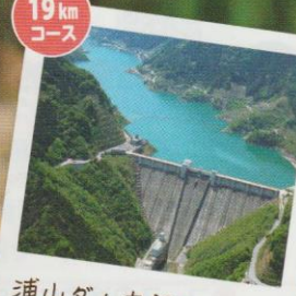
浦山ダム内部ウオーク
